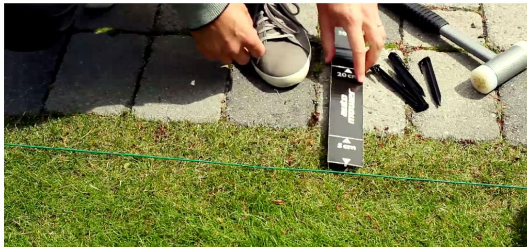
右写真のように高さ5cm未満の障害物エリアでは、30cm離れた位置に設置します。
